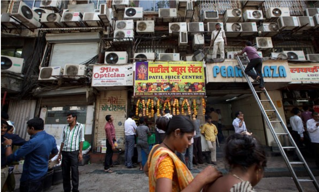
Hindistan’ın Mumbai kentinde tüm cephesi klimalarla kaplı bir bina (2012)
