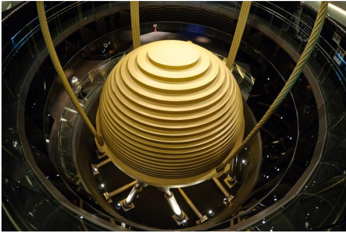
Taipei 101 binasının 660 tonluk aktif kütle sönümleyicisi (87. katta asılı)
