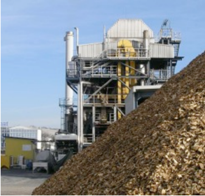
Yongadan üretilen gaz karışımının alkole dönüştürüldüğü tesis (Avustralya)
